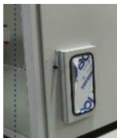
Protetor Frontal acionamento Seccionadora à gás
